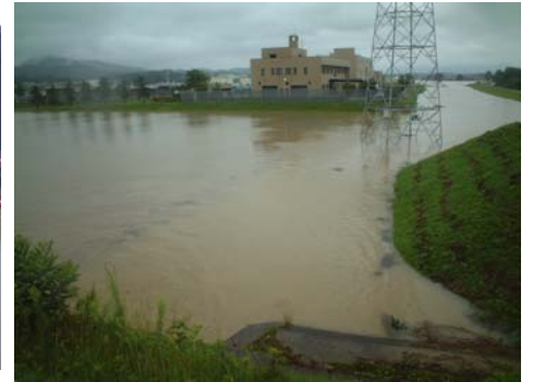
58.4kp右岸 19日(外水) 新真中橋上流右岸
