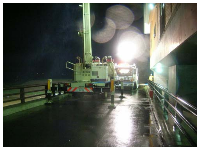
前山川水門の作業状況 照明車と排水ポンプ車 39.6kp右岸 19日19:48
