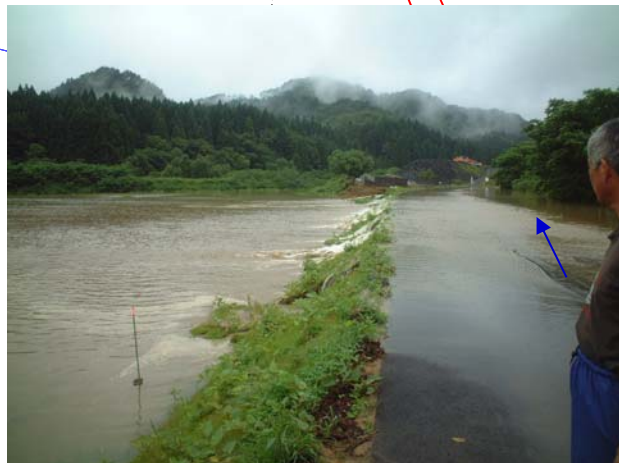
57.6kp左岸 19日12:25(越水)
