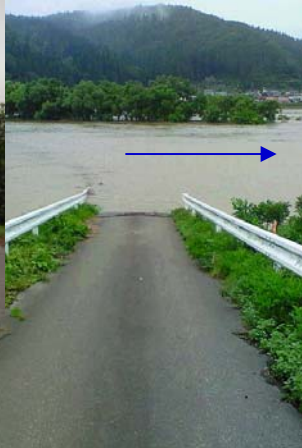
26.0kp右岸 19日 18:07 二ツ井地区 外水
