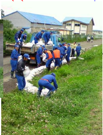
6.4kp左岸 19日 17:45 中川原地区 水防活動状況 月の輪
