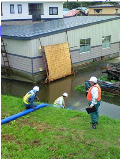
47.6kp左岸 19日12:55(内水)
