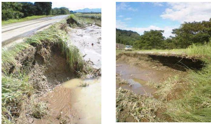
堤防を溢れ出た流水により堤防の斜面が崩れた状況
