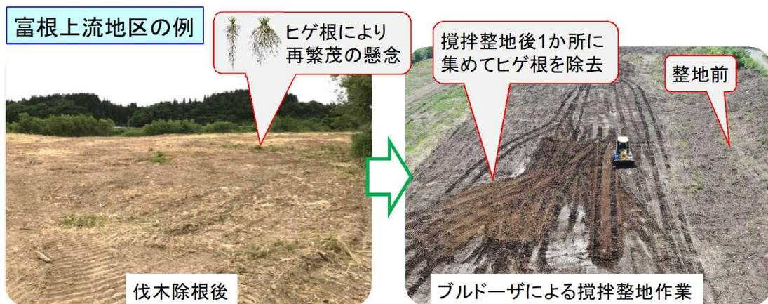
図 7-3 再繁茂抑制策実施例(米代川富根上流地区)
