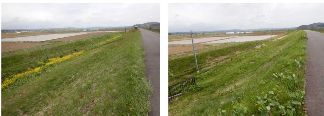
図 7-4 寺勾配化の例(米代川 右岸 13.0k 付近 裏法面)
