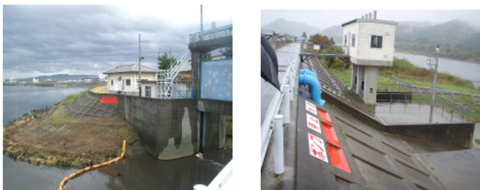
図 7-7 悪土川・比井野川救急排水機場のポンプ停止水位表示
