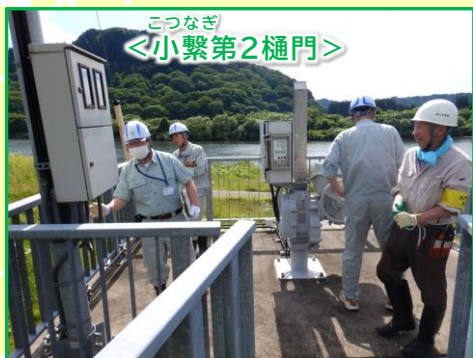
電気設備を点検
