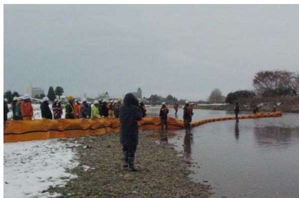
【河川横断設置訓練】
