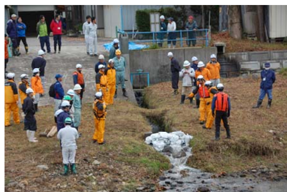
【小水路流出防止工設置訓練】
