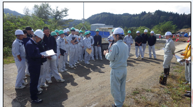
【能代地区線形改良工事現場】
