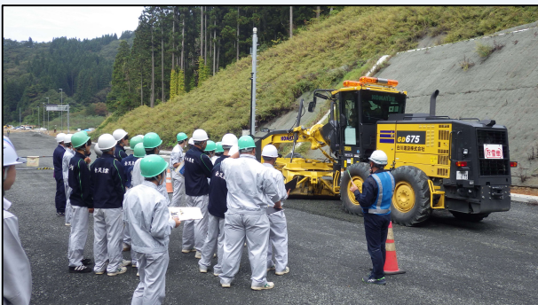
【二ツ井今泉道路工事現場】
