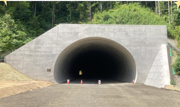
▲大館市側より撮影
