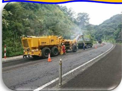
アスファルト舗装を路面切削機で約5cm削ります。切削廃材は、路面切削機前方に設置されているベルトコンベアにより、ダンプトラックに直接積み込みます。
