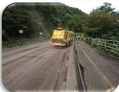
路面切削機で削った後の切削屑やダストをブラシと吸引機を使って収集し、路面をきれいにします。
