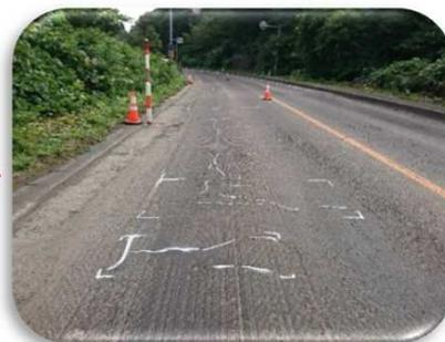
削った後の路面を調査し、有害なひび割れ等がある箇所には、クラック抑制シートの貼付けや舗装打換え等の処置を施した後、舗装を施工します。
