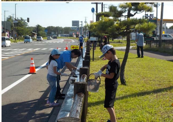
防護柵表面の汚れを落としてからペンキ塗り♪ 親子参加者もいました。 暑かったけれど、楽しみながら作業しました!
