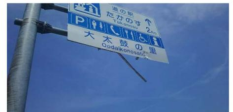
【高さ超過車両による標識の損傷状況】
