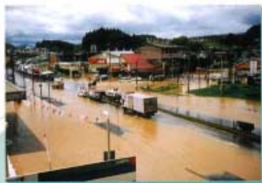
二本松水位観測所付近の国道4号（二本松市）
