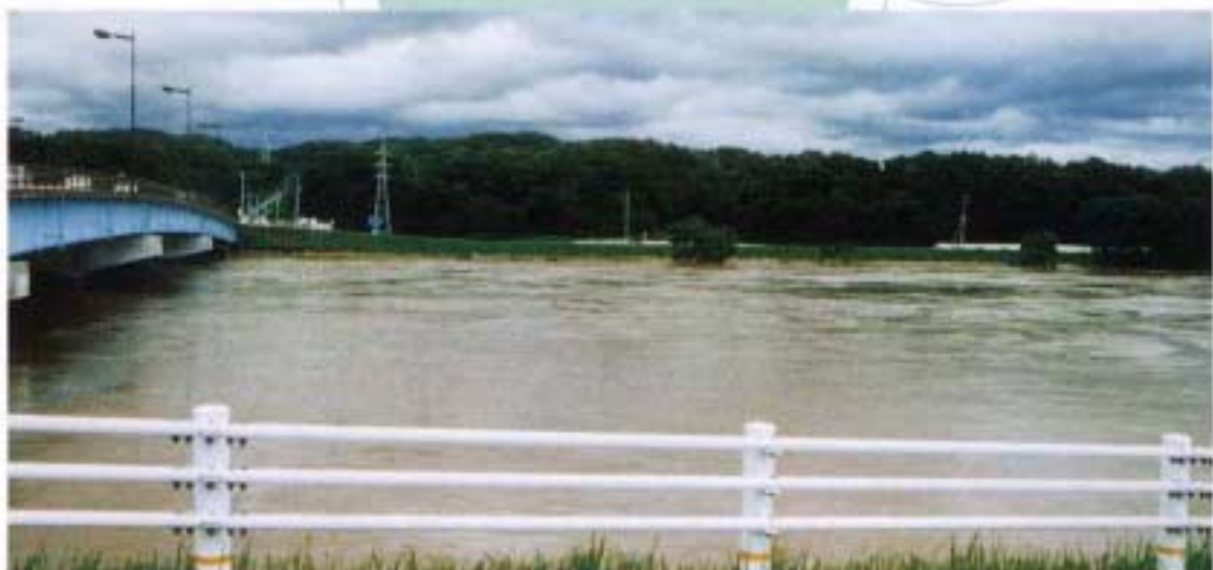
郡山市 阿武隈川 安原橋付近（洪水時）7月11日8:30頃
