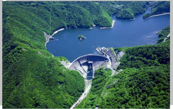
《現在の湯田ダム(上空より)》
