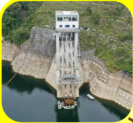
右岸にある取水設備。 取水を止め、船で近づいて作業します。
