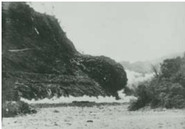
昭和25年に行われた猿岩の発破は56トンの爆薬を使用した稀にみる大爆破工事でした。
