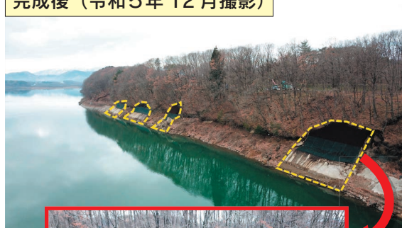
完成後 (令和5年12月撮影)
