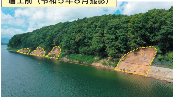
着工前 (令和5年8月撮影)
