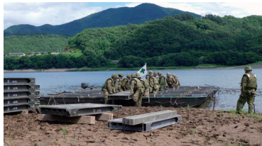
門橋構築訓練 (5舟5導板で3.5トンの車輛を積載可能)
