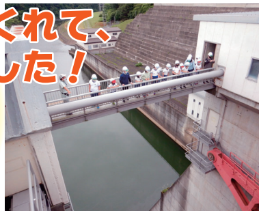
ゲート室から間近にクレストゲートを見学
