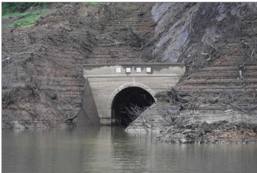
⑤ 船上巡視より(猿岩隧道坑口下流側)
