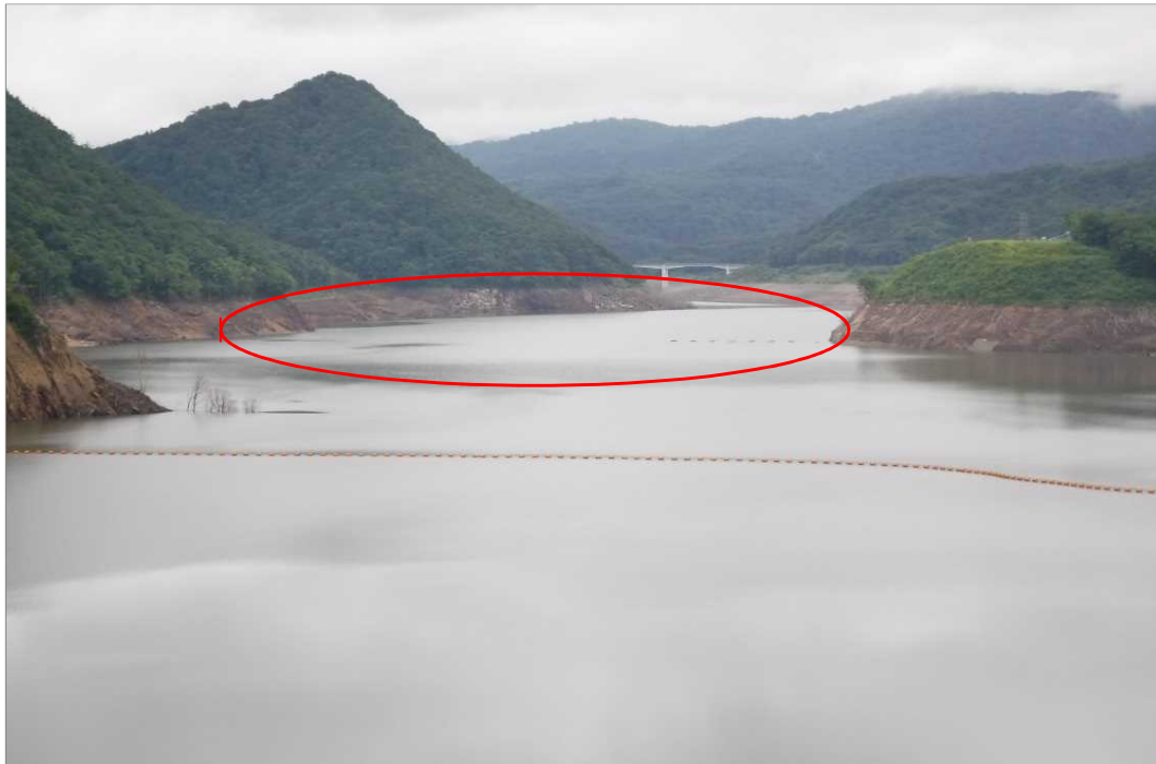
①胆沢ダム天端より(石淵ダム)
