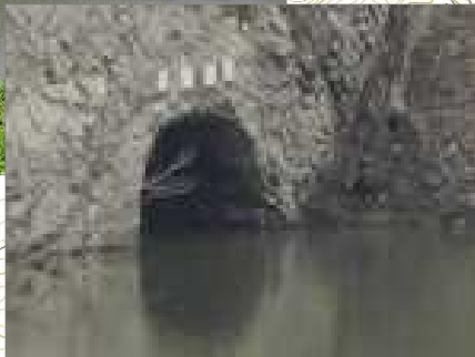
⑦おろせ広場より(隧道坑口上流側)
