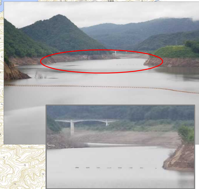
①胆沢ダム天端より(石淵ダム)
