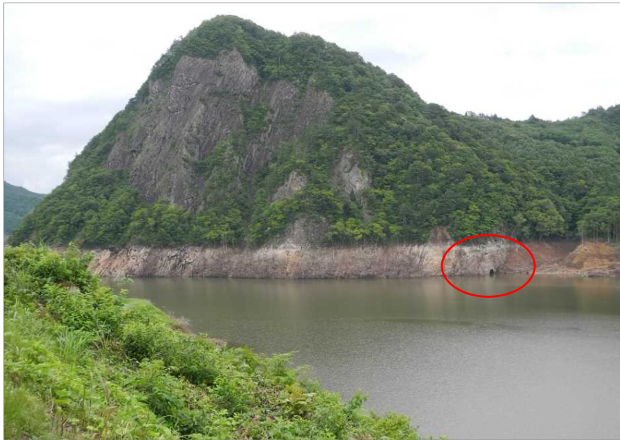
⑦おろせ広場より(猿岩隧道坑口上流側)
