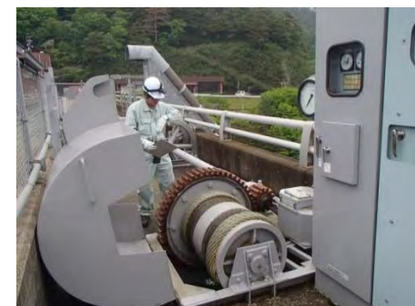
放流に向けたダム放流施設の 点検実施訓練
