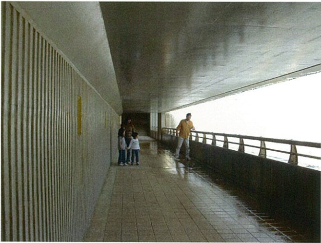
貯砂ダム通廊
