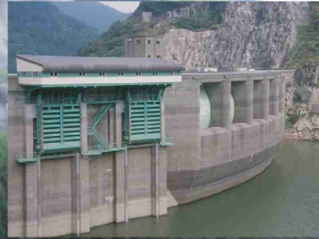
堤頂部上流面(キャタピラゲート)
