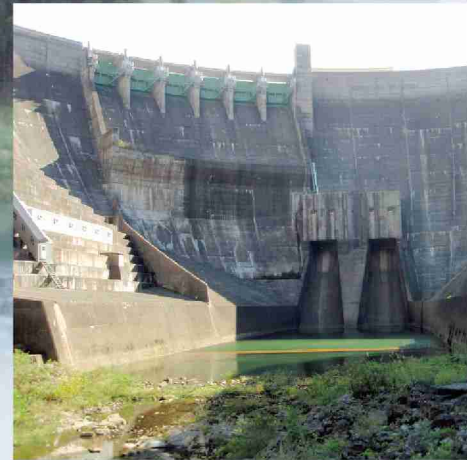
コンジットゲート室とクレストゲート
