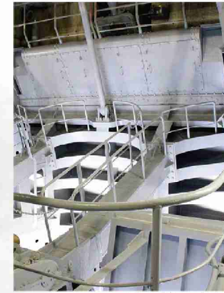
コンジットゲート室内部
