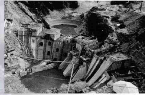
建設中 昭和37年10月
