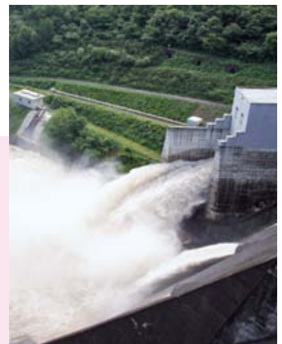
ダム放流状況
