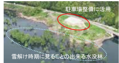
掘削土砂活用状況
