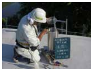
観測施設の点検状況
