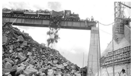
石淵ダムの施工状況（S27.8ロック材運搬）
