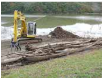
流木引き上げ状況
