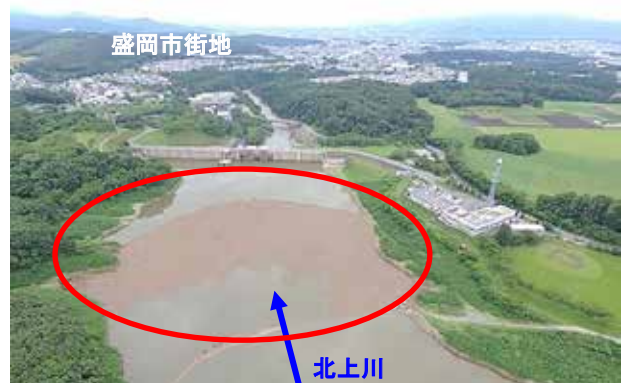
四十四田ダムでの流木の捕捉状況
