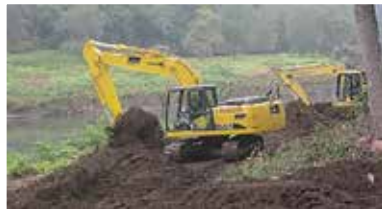
堆積土砂掘削状況
