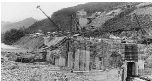
田瀬ダムの施工状況（S18.9本体打設）
