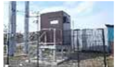
局舎耐水化対策（嵩上げ）
