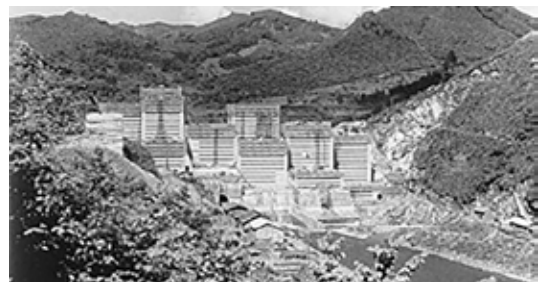
工事再開後の田瀬ダム（S27.5）
