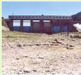
干上がった石淵ダム
