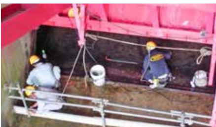
ゲート設備の点検
