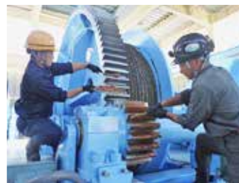
開閉機ギヤへのグリース塗布状況
