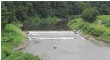
四十四田ダム貯砂床止工 (H28.12竣工)
