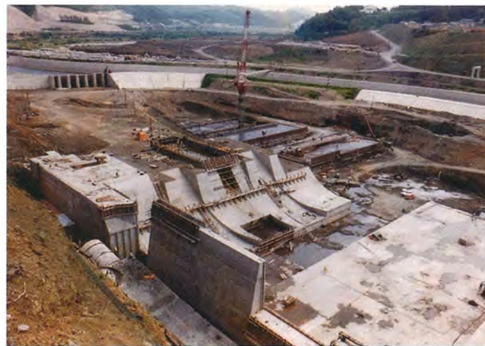
コンクリート堤体打設
