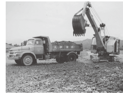
雫石川での骨材採取状況
