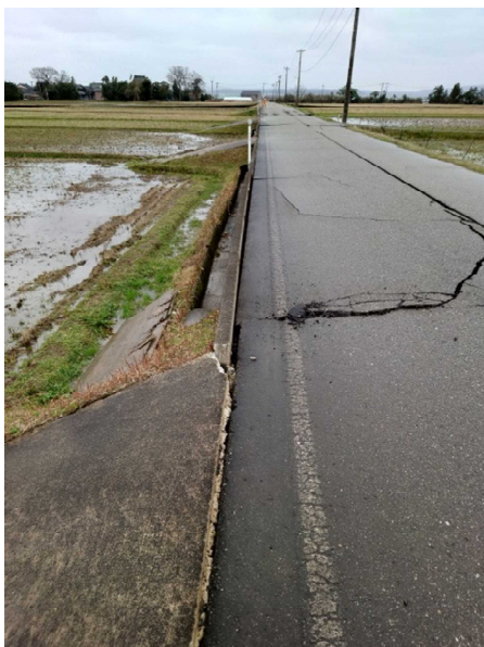
亀裂の延長計測
