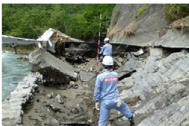
▲ 被災状況調査
