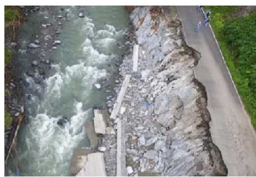
▲ ドローンを活用した被災状況調査
