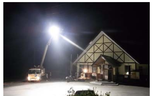
▲ 避難所への照明車設置
