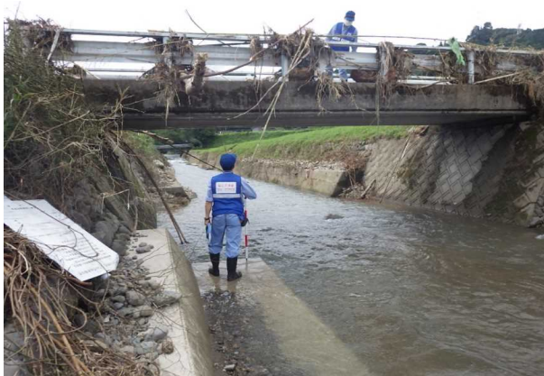
▲ 橋梁の損傷調査状況
