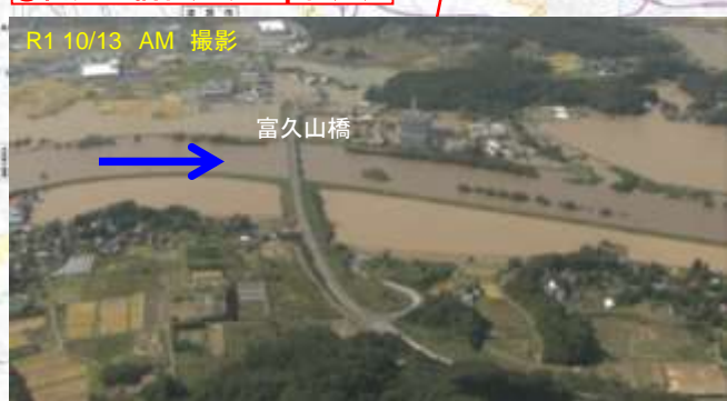
②富久山橋付近(81kp付近)
