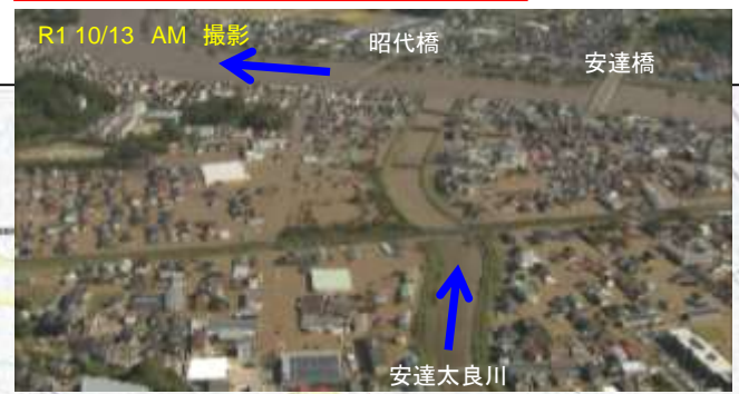
①安達太良川合流点付近(68kp付近)
