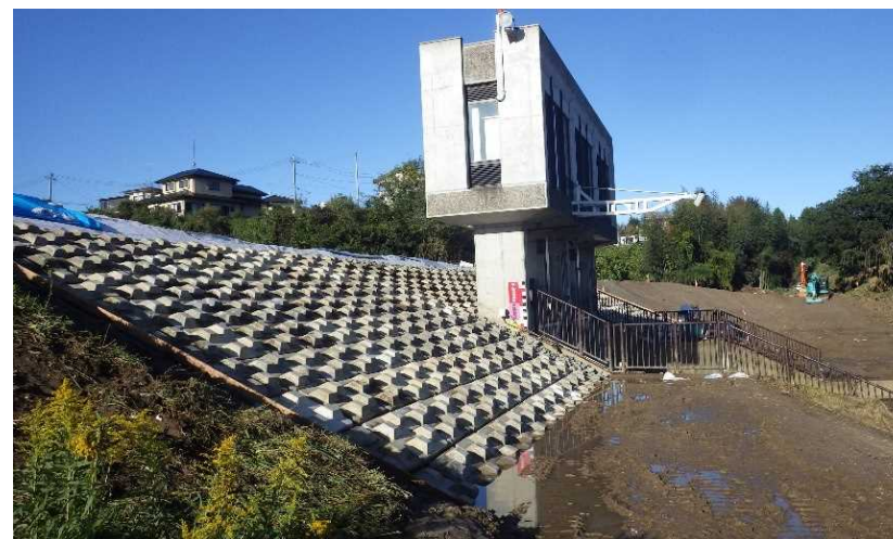
(締切盛土の施工状況)
