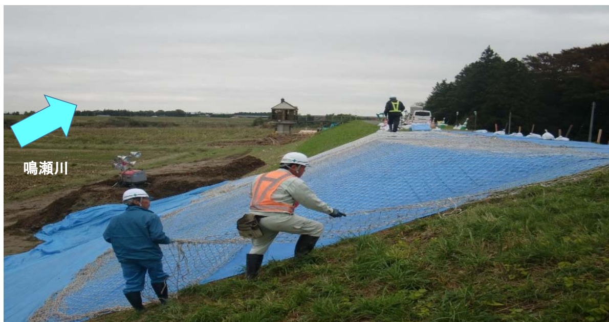
盛土施工完了 (降雨に備えた対応状況)
