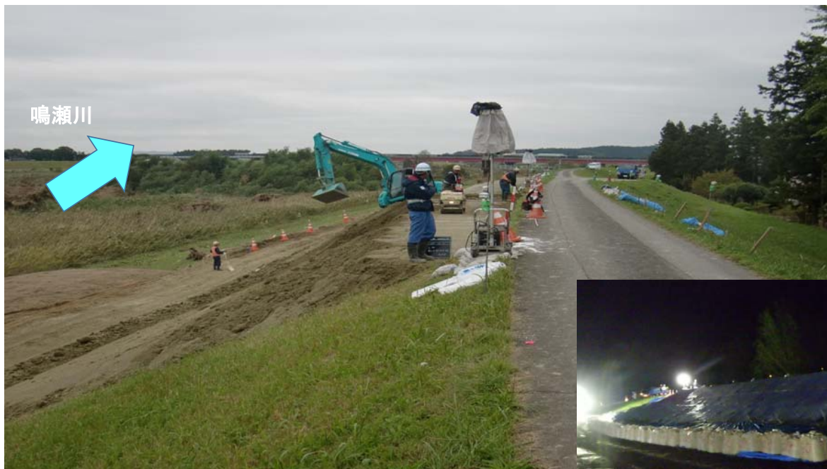
盛土施工完了
