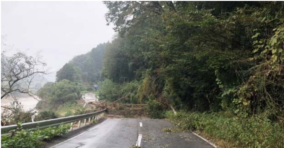
啓開前の状況(10月13日)
