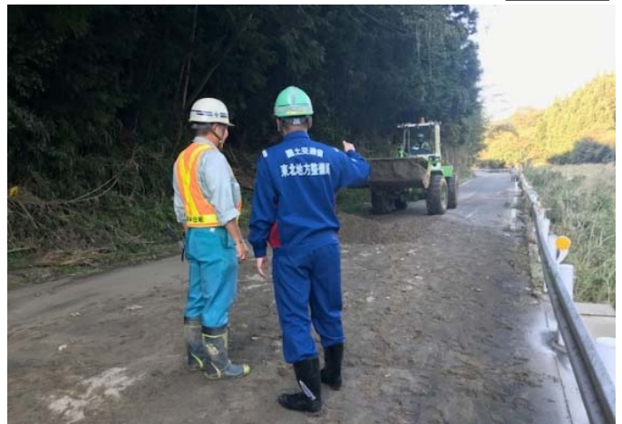
啓開後の状況(10月16日)
