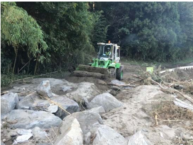
啓開作業状況(10月16日)
