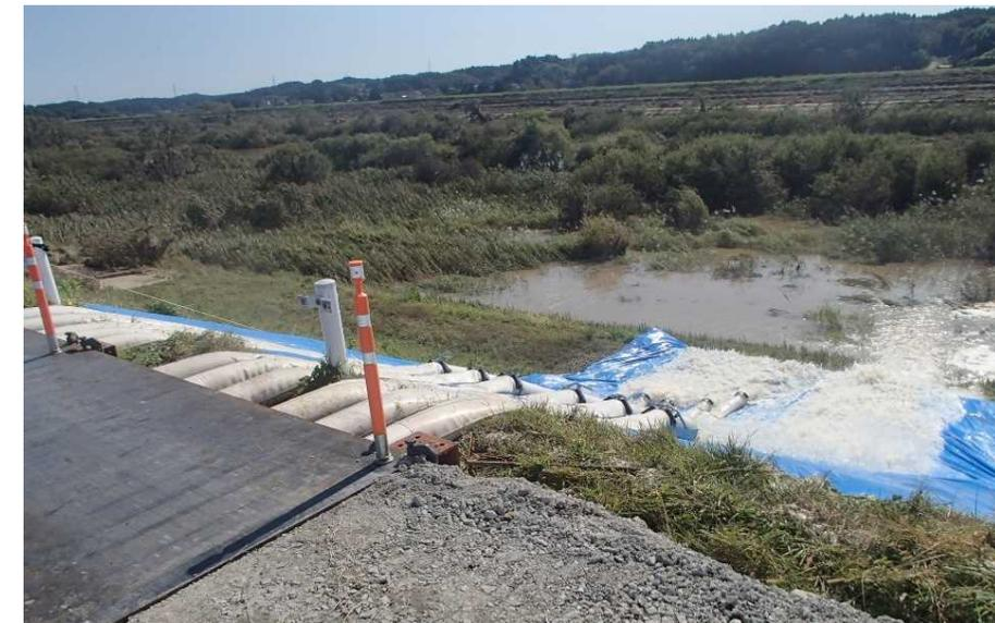
応急対策班 鳴瀬川水系吉田川(左岸14k200) 排水ポンプ車による排水作業を実施
