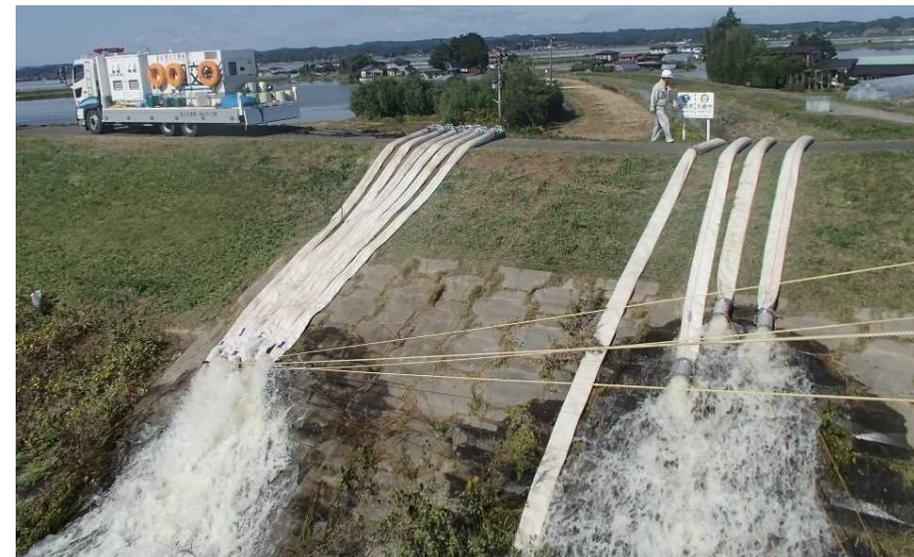
応急対策班 鳴瀬川水系吉田川(左岸11k800) 排水ポンプ車による排水作業を実施
