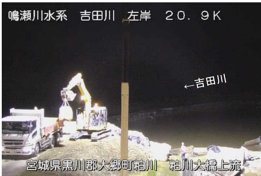
緊急復旧状況
