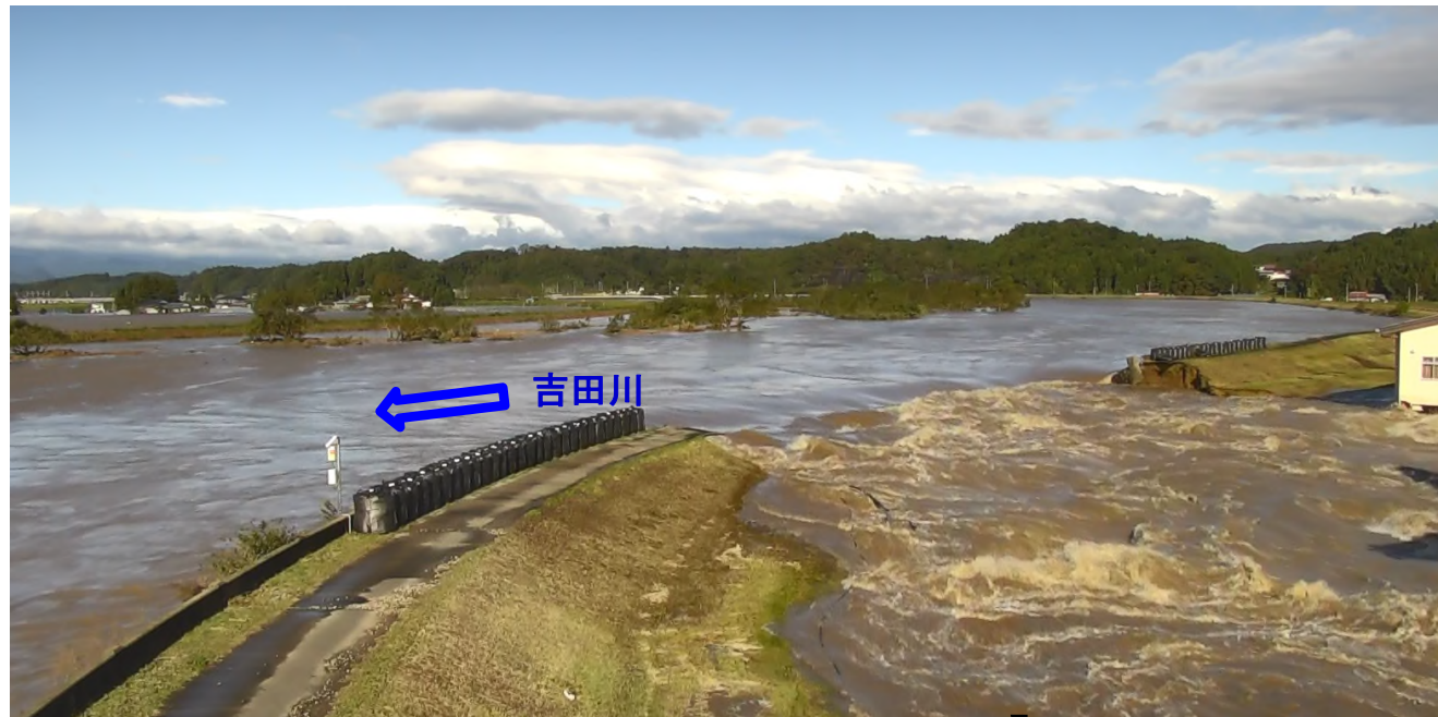
【吉田川左岸20.9k 破堤箇所】
