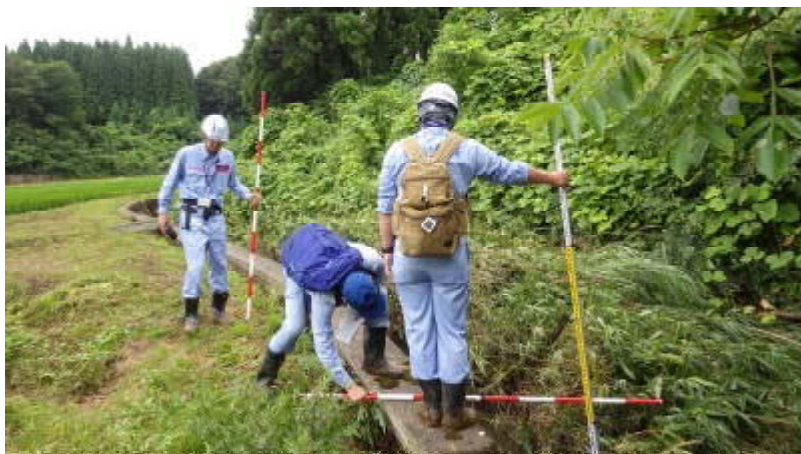
被災状況調査（大仙市：普通河川袖山川）
