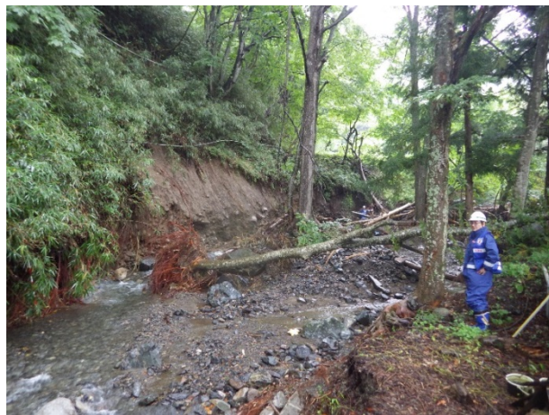
▲(普通河川)伊佐内沢川下流から全景被災状況
