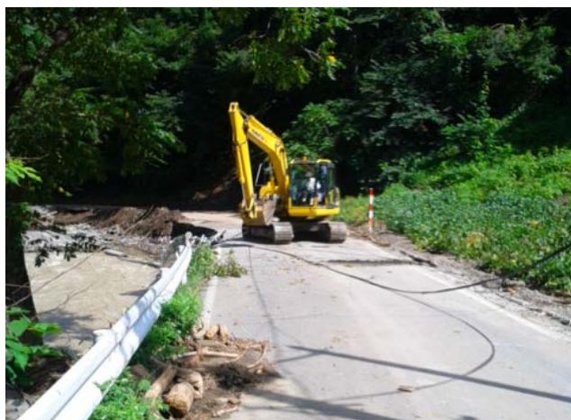
国道340号岩泉町平井地区での道路啓開の状況
