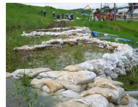
建設業者の重機を活用した月の輪工法による漏水対策を実施
