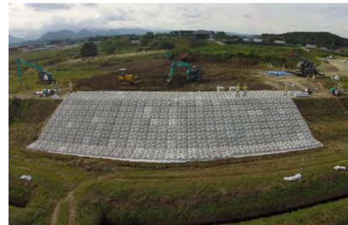
護岸工完了全景
