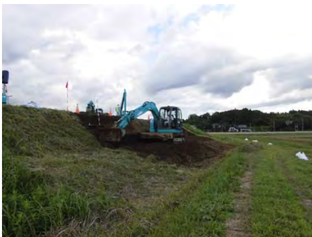
崩落土砂の除去
