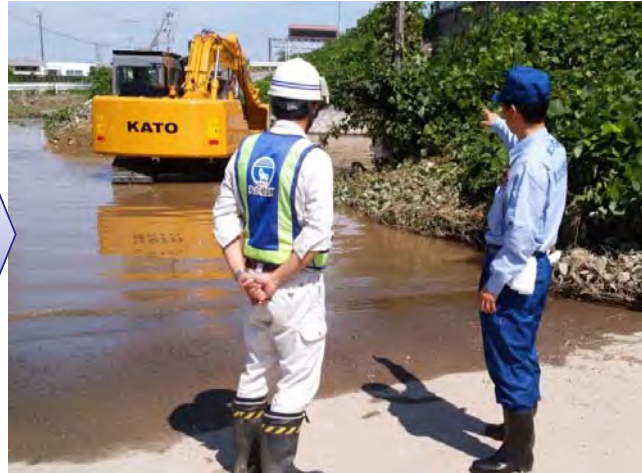
決壊箇所までの工事用道路の敷設
