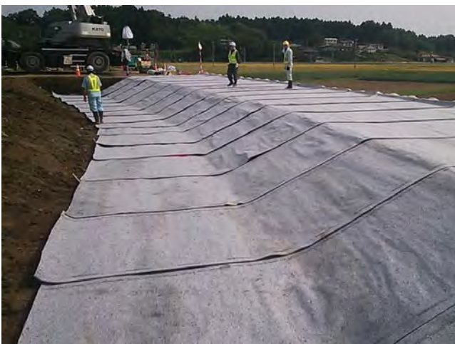
遮水シート敷設完了
