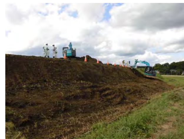
崩落土砂の除去
