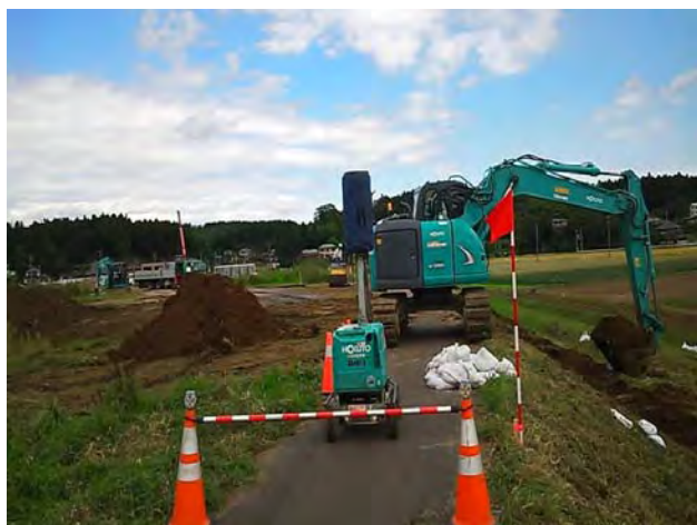
崩落土砂の除去
