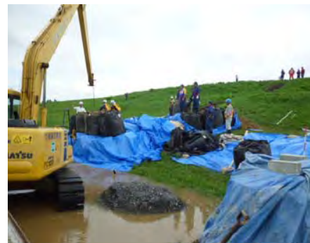
建設業者の重機を活用した月の輪工法による漏水対策を実施
