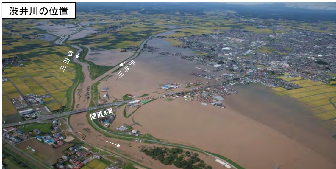
渋井川の堤防決壊箇所
