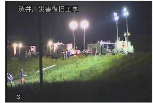
渋井川緊急復旧箇所における 排水ポンプの稼働状況
