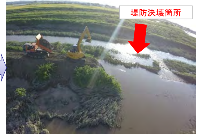
下流工区で堤防盛立に着手
