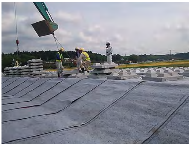
護岸ブロック設置状況
