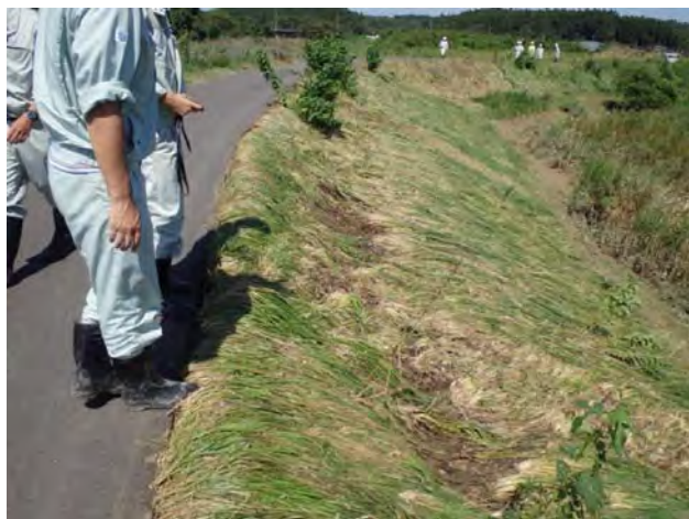
越水箇所の確認
