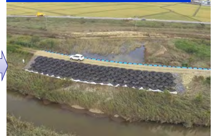
護岸での補強を完了した中流工区の堤防
