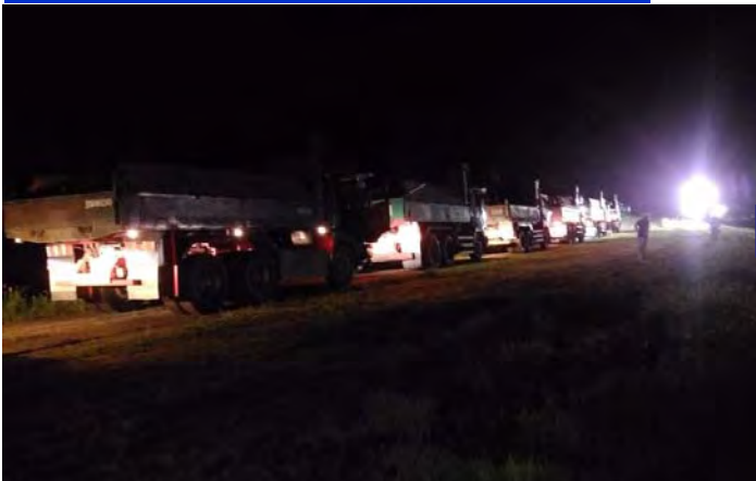
昼夜を分かたず緊急復旧盛土材を搬入
