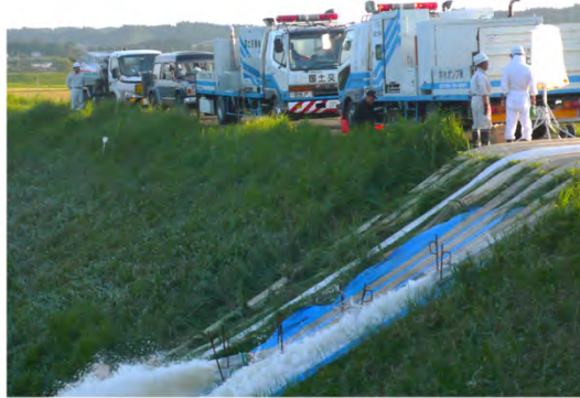
松和田排水機場での排水ポンプ稼働状況 (吉田川左岸23.6k付近)
