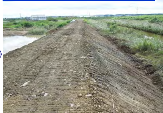
下流工区での盛立完了の様子
