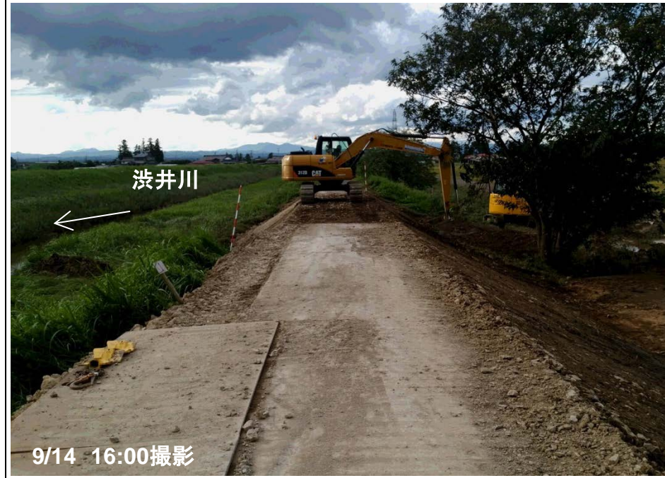
西荒井上流工区 復旧状況
