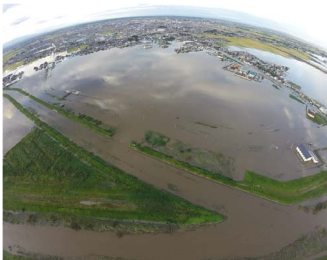
堤防決壊箇所と浸水エリアの把握
