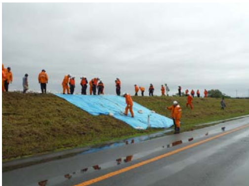
シート張り工法により 堤防の洗掘対策を実施
