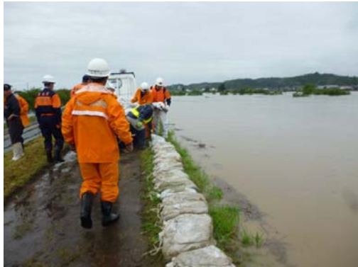
土のう積み工法により堤防の 越水を防止
