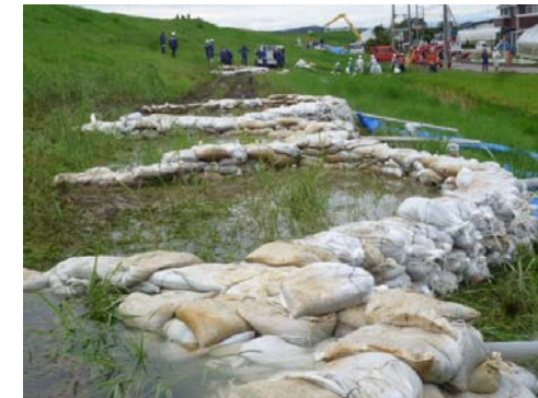
建設業者の重機を活用した月の輪工法による漏水対策を実施
