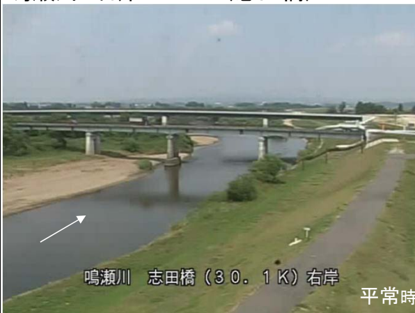
鳴瀬川 右岸 30.1k (志田橋)
