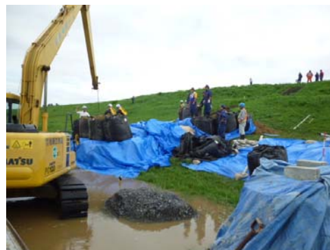
建設業者の重機を活用した月の輪工法による漏水対策を実施
