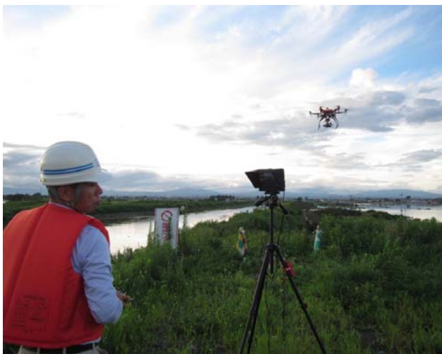
UAVによる被災状況の調査
