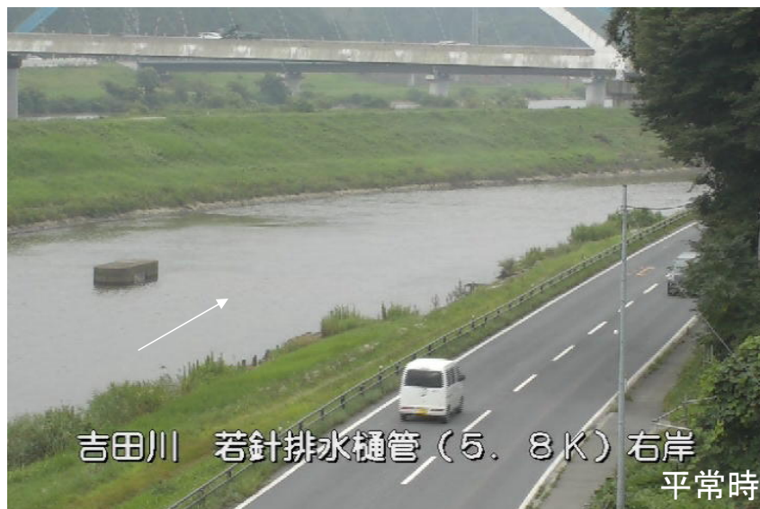
吉田川 右岸 5.8k (若針排水樋管)
