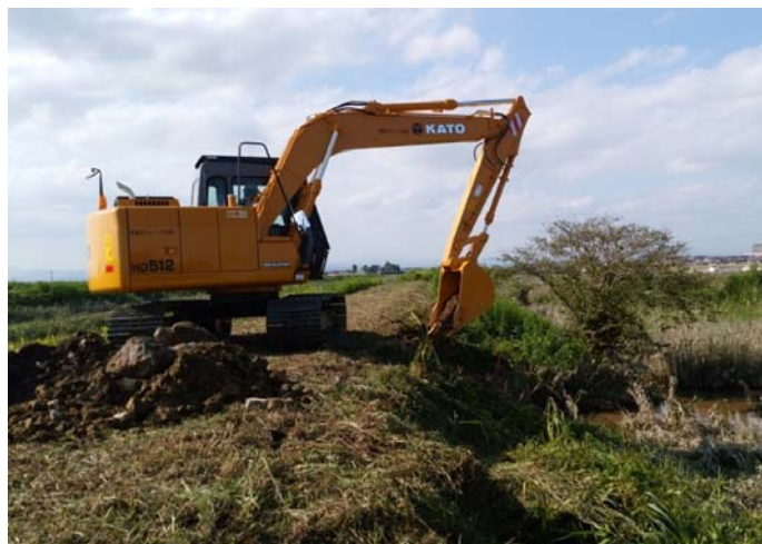
漏水箇所の補修
