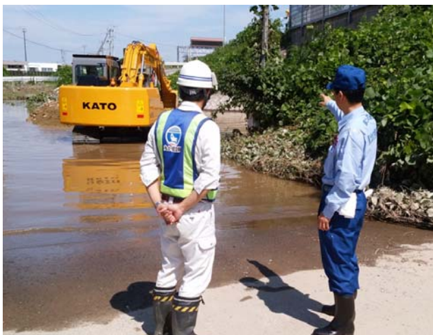
決壊箇所までの工事用道路の敷設
