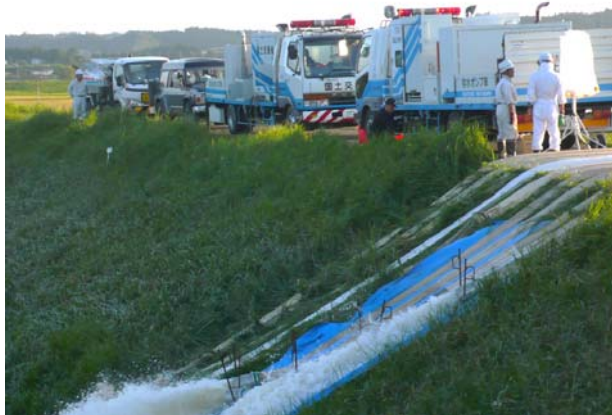
大和町落合桧和田地先における排水ポンプ稼働状況 (吉田川左岸23.6k付近)
