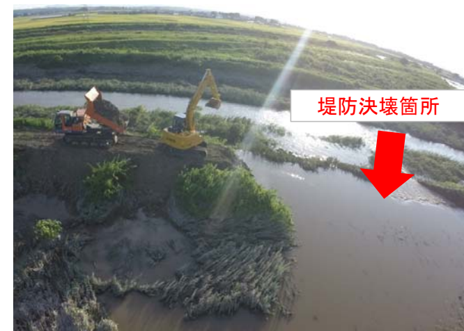
堤防決壊箇所への土砂投入
