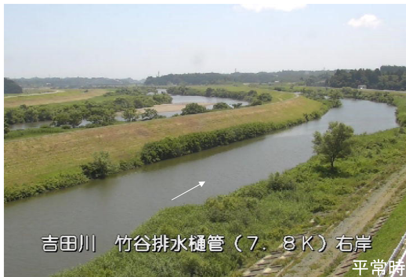
吉田川 右岸 7.8k (竹谷排水樋管)
