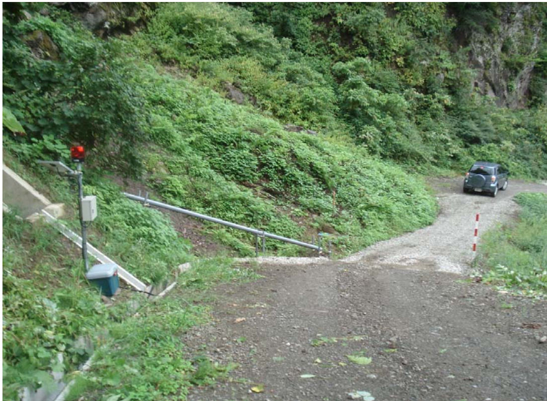
※地盤伸縮計、回転灯の設置状況
