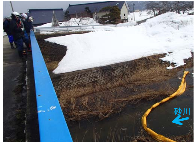
砂川の状況確認(橋本橋) →
