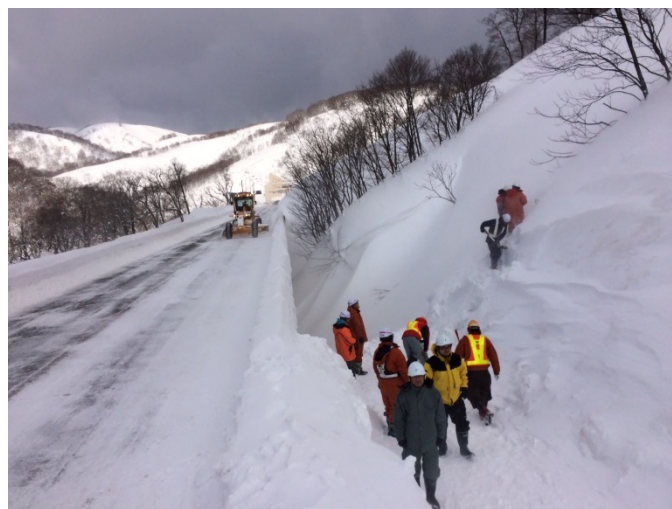
専門家による現地調査
