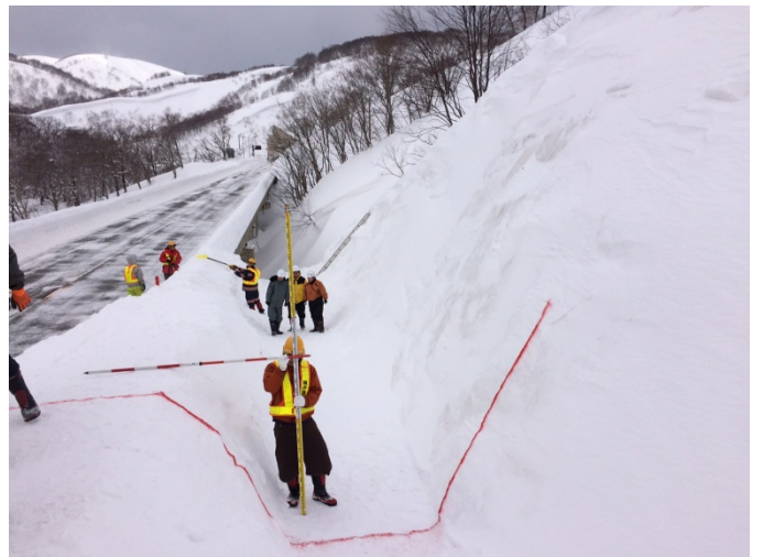
雪崩柵背面の堆雪スペース確保作業
