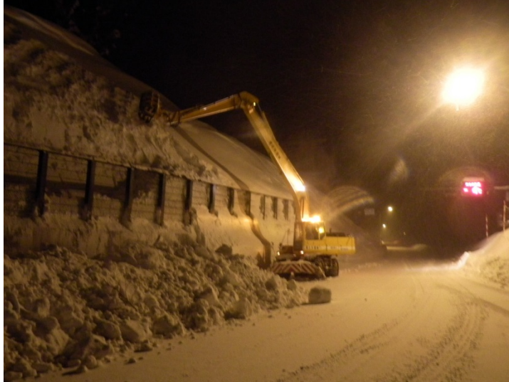
雪崩柵背面の堆雪スペース確保作業
