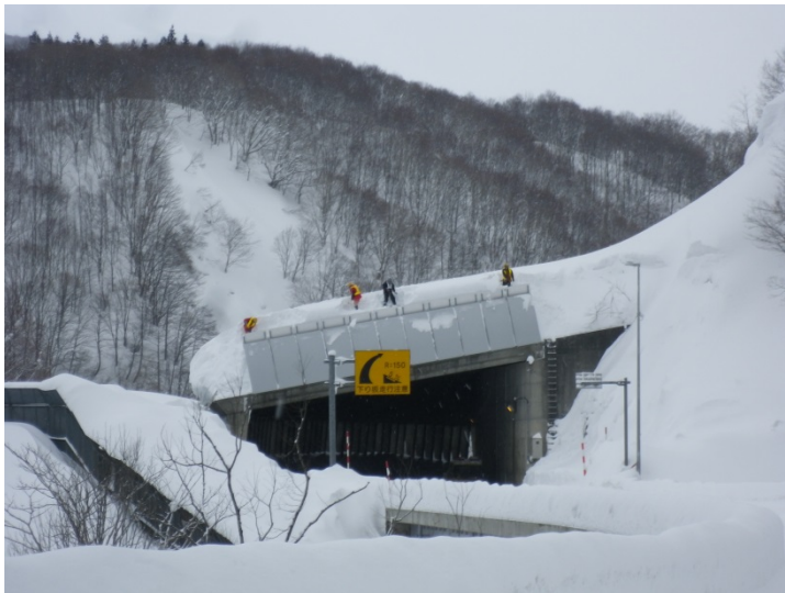
雪庇除去作業
