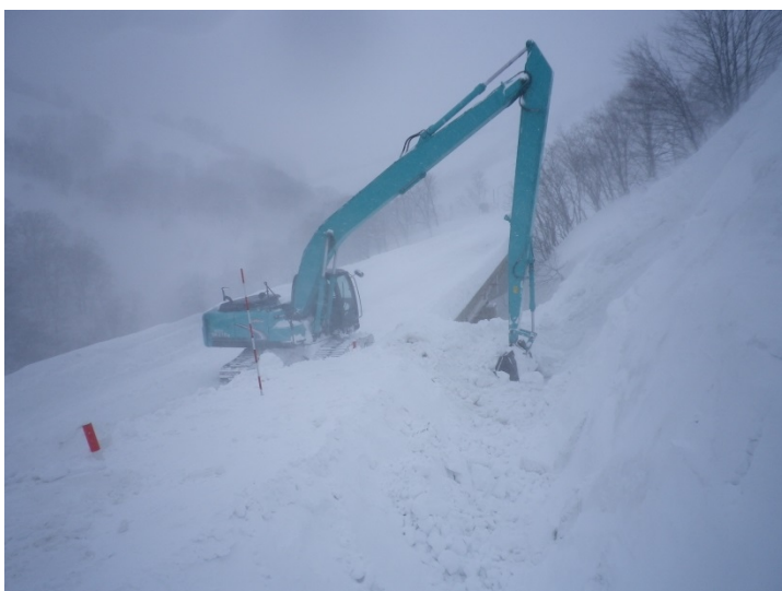
雪崩発生箇所の雪堤および導流路の設置作業
