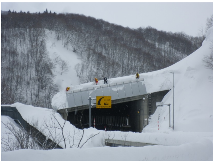
雪庇除去作業
