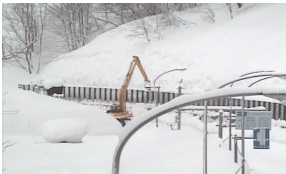
雪崩柵背面の堆雪スペース確保作業
