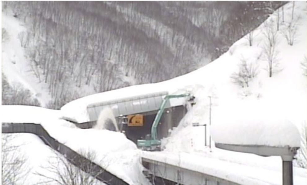
雪庇除去作業
